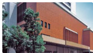
3 新橋演舞場バックヤード コーティング施工
